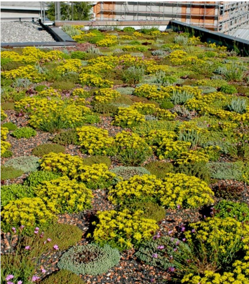
Egal wofür man sich entscheidet: der Wasserabfluss muss gut geplant und gewartet sein und die Begrünung sollte rundherum von einem gut 30 cm breiten Kiesrand begrenzt sein. Auch schiefe Dächer können begrünt werden. In diesem Fall werden zwischen Drainage- und Substratschicht eigene Haltevorrichtungen eingelegt, die das Abrutschen der Substratschicht verhindern. An Stelle einzelner Pflänzchen werden Sedum- matten aufgelegt, auf denen die Pflanzen bereits gut verwurzelt sind.
