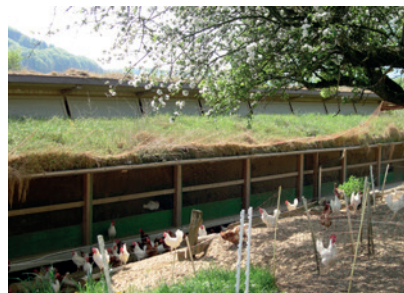
Kühlende Leichtdachbegrünung für einen Legehennenstall (Schweiz)
