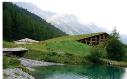
Tennishalle in Suldén – eine der ältesten Gründächer in Südtirol
