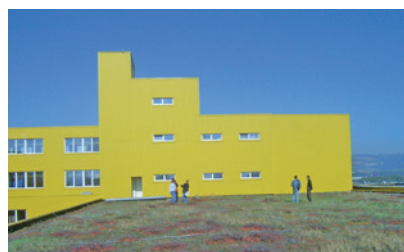
Industriegebäude mit 35.000m 2 Gründach in Linz
