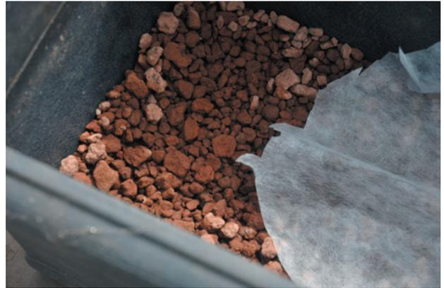
***Dränschicht aus Lava mit Vlies als Trennung zum Substrat***
